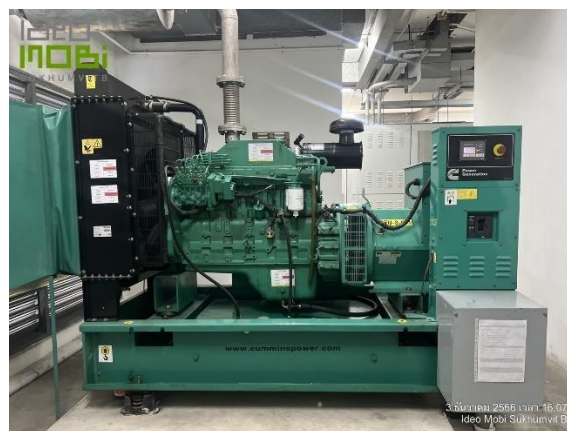
ภาพที่ 24 เครื่องกำเนิดไฟฟ้าสำรอง
