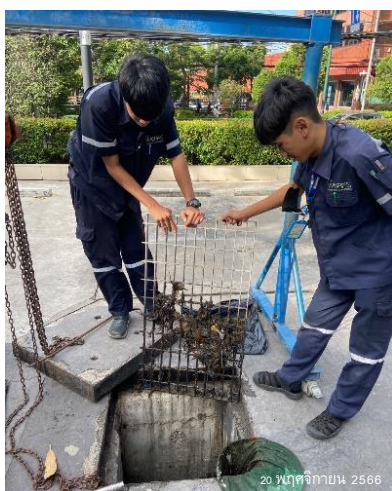
ภาพที่ 13 ตะแกรงดักขยะที่ Man Hole สุดท้าย
